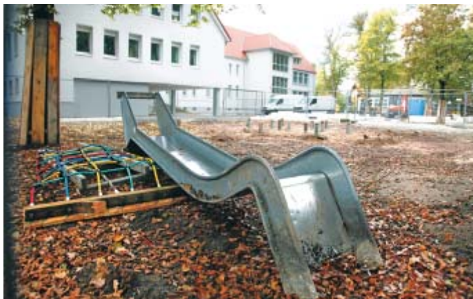
Abgebaut: Das Klettergerüst auf dem Pausenhof der Marienschule macht Platz für den Bagger. Wegen der Munitionsfunde wird rund um das Spielgerät jetzt der Boden abgetragen. FOTO: ROLAND THÖRING
